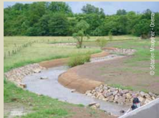
Création de la dérivation définitive du Bruchbach suite au franchissement par la LGV Est
