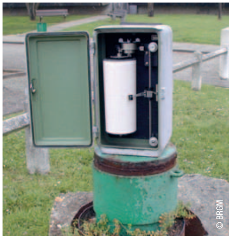
Piezomètre mesurant en continu les variations du niveau des eaux souterraines.
