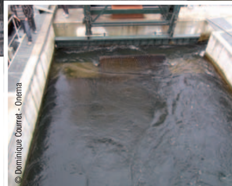
© Dominique Courret - Onema Prise d'eau ichtyocompatible de Masseys sur le Gave d'Oloron (hors d'eau et en eau) constituée d'un plan de grille incliné à 24° par rapport à l'horizontale, avec un espacement entre barreau de 2 cm, et 2 exutoires au sommet alimentés à hauteur de 10% du débit turbiné.
