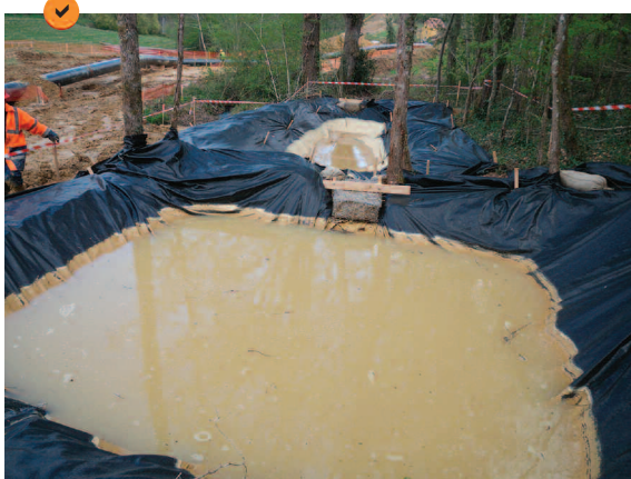
Dispositif de surverse à gabion de paille.
